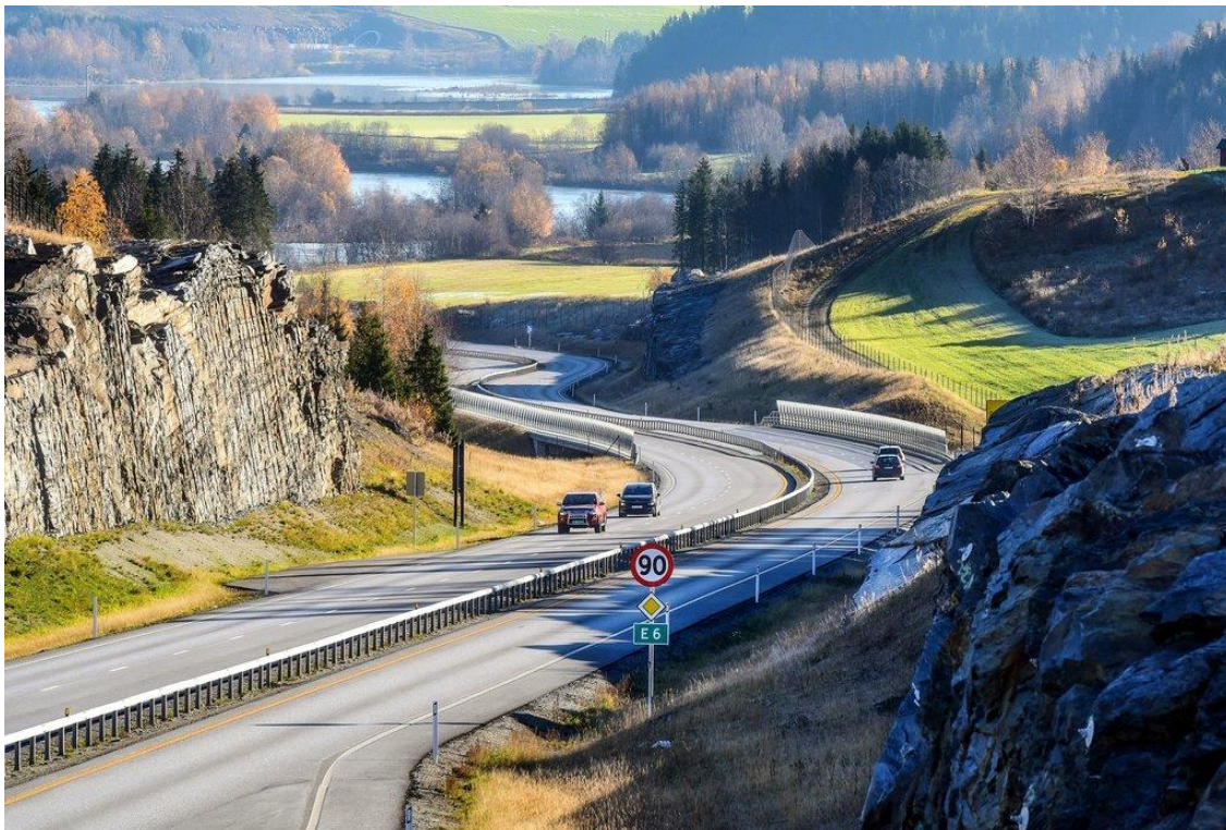
Foto: Knut Opeide, Statens vegvesen
